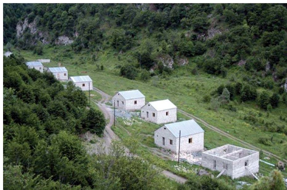
2003, Karabagh, construction du village de Knaravan dans les territoires libérés de Kelbadjar.
