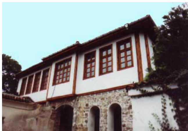
Le nouveau bâtiment de l'école : en rénovation
