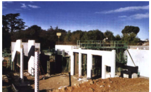
L'école en construction, décembre 2002
